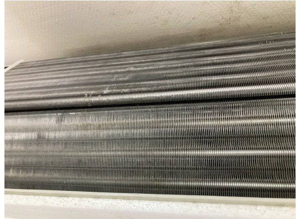
15.エアコンクリーニング
