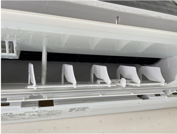
12.エアコンクリーニング
