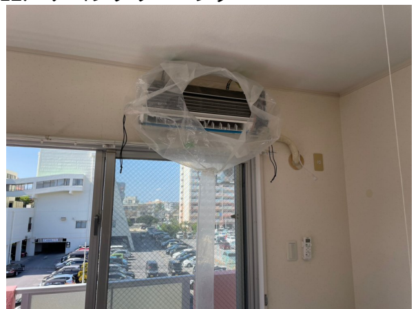
12.エアコンクリーニング
