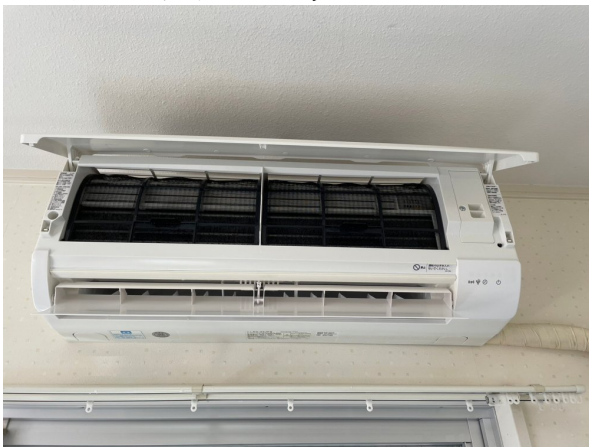
12.エアコンクリーニング
