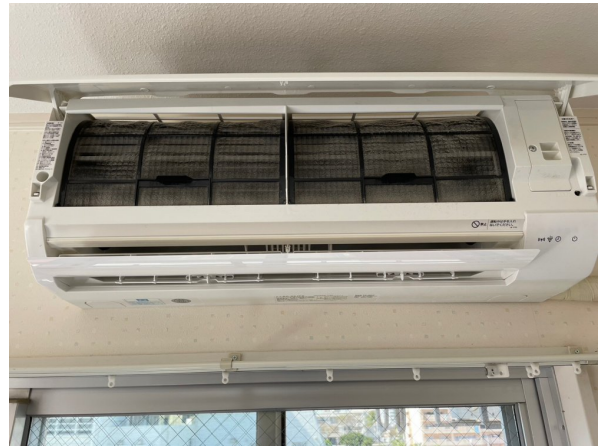
12.エアコンクリーニング
