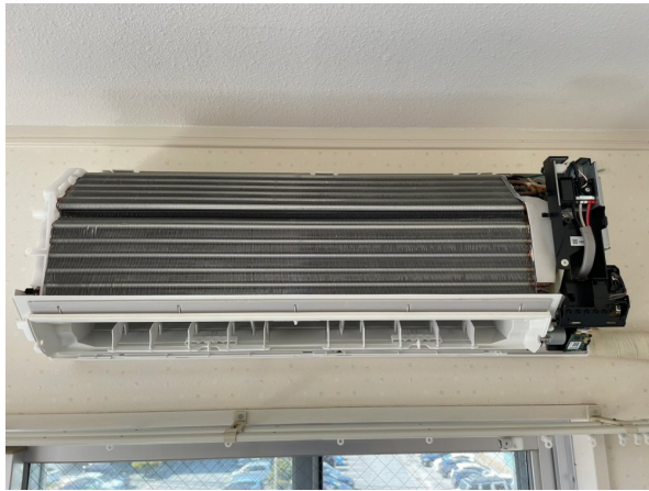
12.エアコンクリーニング
