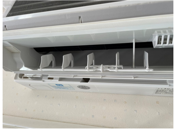
12.エアコンクリーニング
