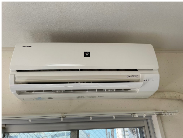
12.エアコンクリーニング
