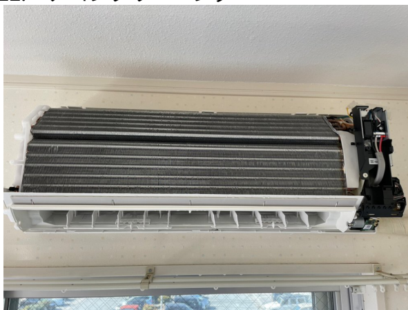
12.エアコンクリーニング
