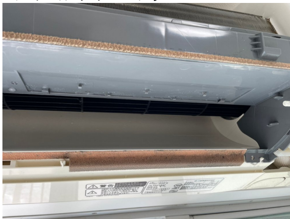
11.エアコンクリーニング
