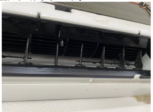
12.エアコンクリーニング
