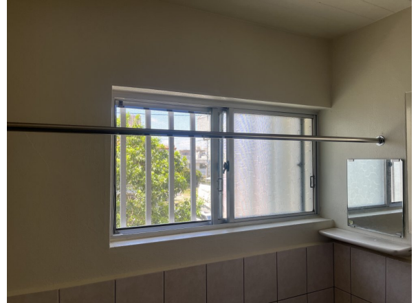
風呂場パイプ取付
