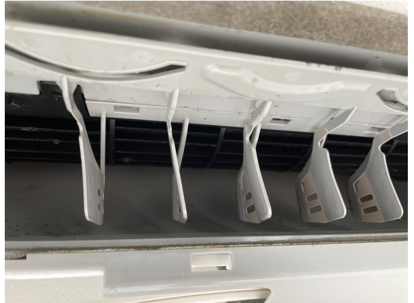
15.エアコンクリーニング
