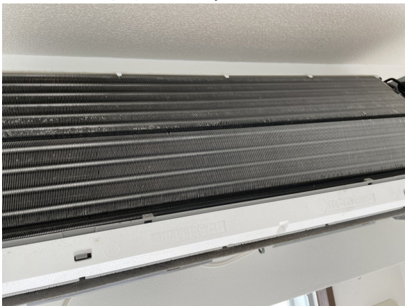
15.エアコンクリーニング
