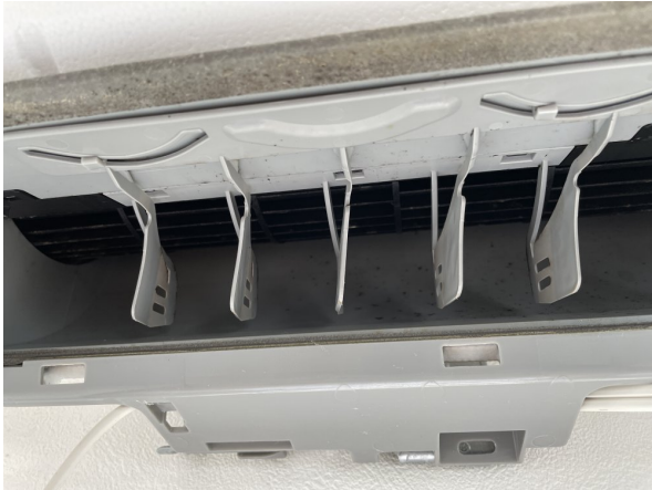
15.エアコンクリーニング
