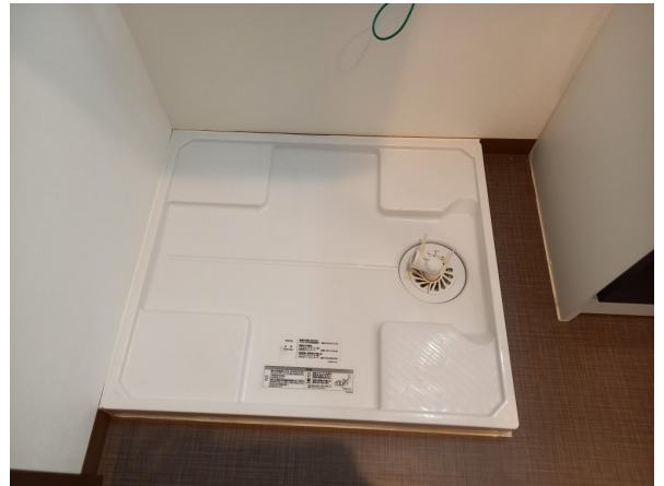
7.洗濯機防水パン
