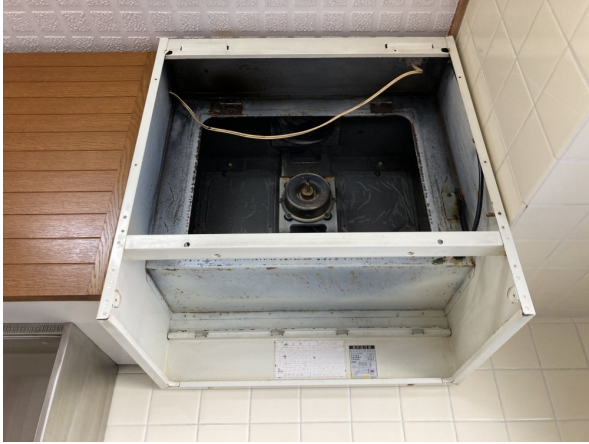
レンジフード部品設置しています
