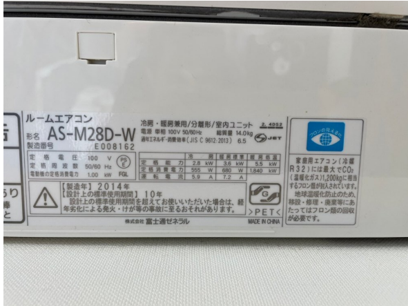
22.エアコンクリーニング
