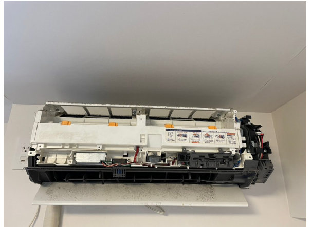
22.エアコンクリーニング
