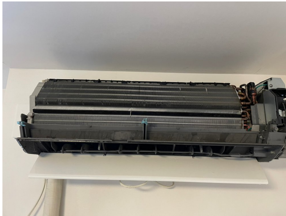
22.エアコンクリーニング
