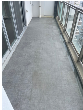
34.床剥離洗浄after
