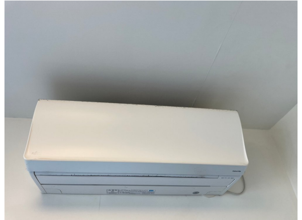
22.エアコンクリーニング
