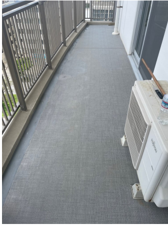
34.床剥離洗浄after
