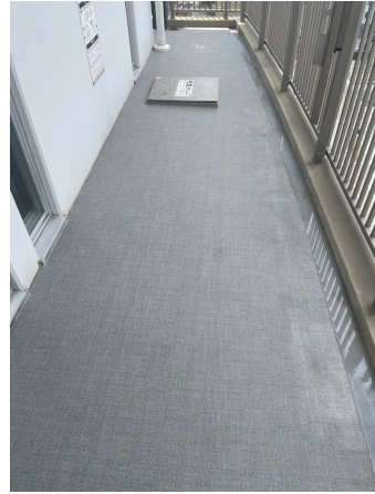
34.床剥離洗浄after
