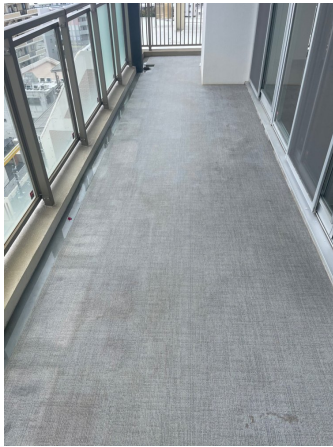
34.床剥離洗浄after
