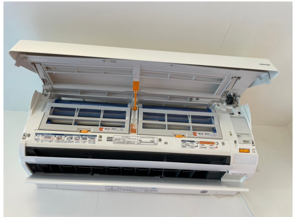
22.エアコンクリーニング
