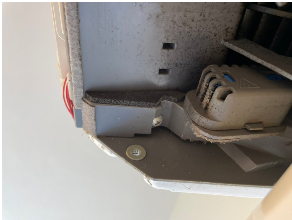
22.エアコンクリーニング
