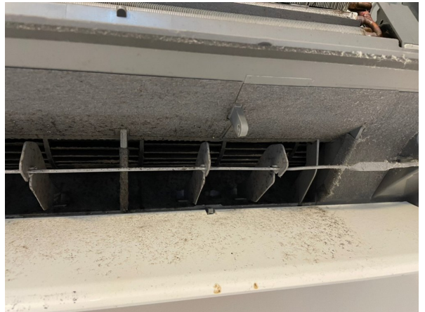
22.エアコンクリーニング
