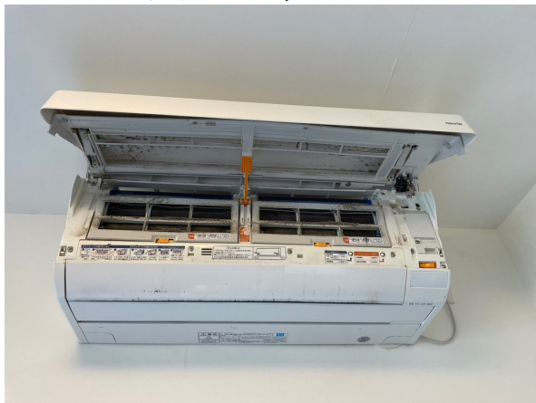
22.エアコンクリーニング
