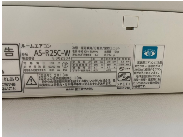
22.エアコンクリーニング
