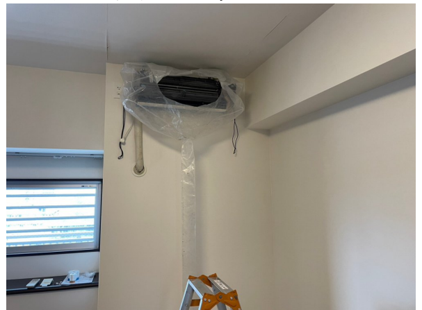
22.エアコンクリーニング
