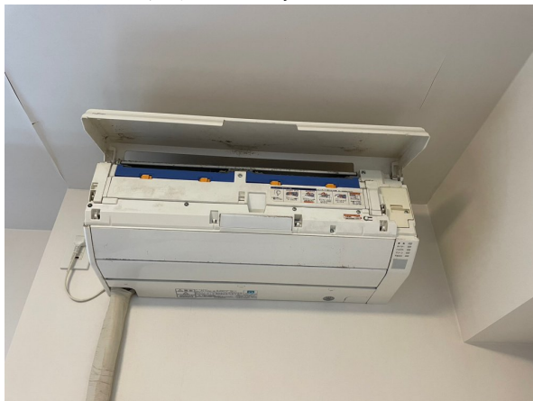
22.エアコンクリーニング
