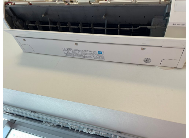
22.エアコンクリーニング
