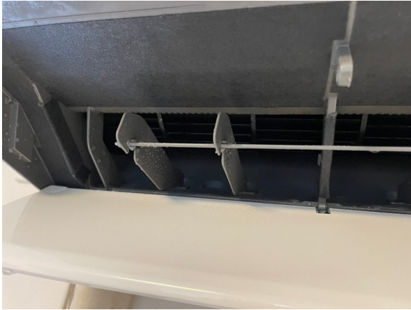
22.エアコンクリーニング
