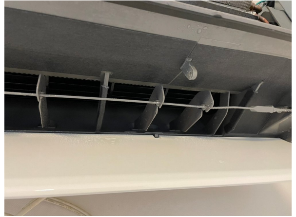
22.エアコンクリーニング
