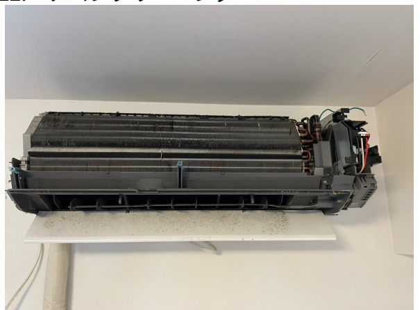
22.エアコンクリーニング
