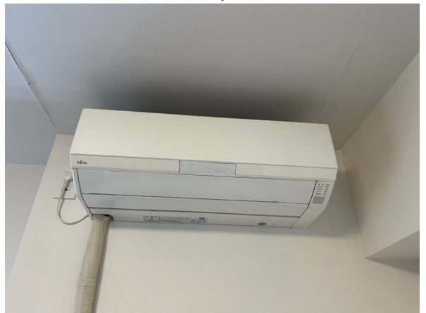
22.エアコンクリーニング
