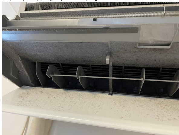
22.エアコンクリーニング
