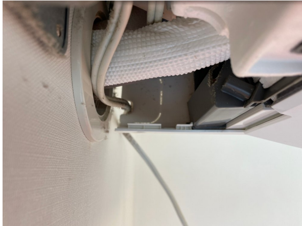
22.エアコンクリーニング
