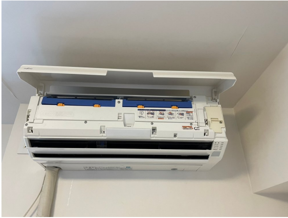
22.エアコンクリーニング
