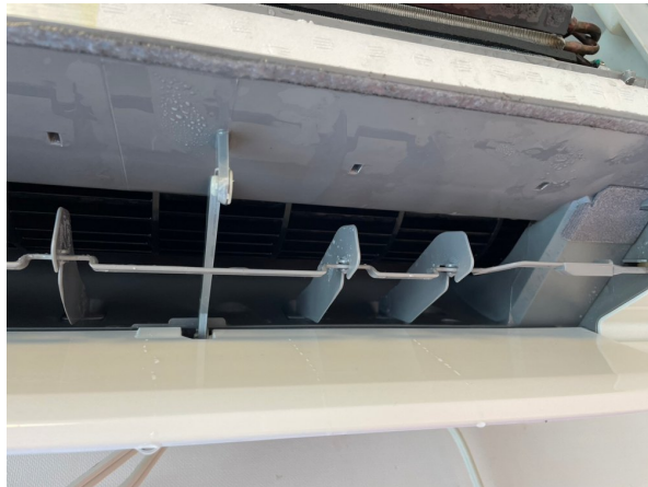
22.エアコンクリーニング
