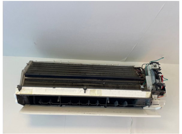
22.エアコンクリーニング
