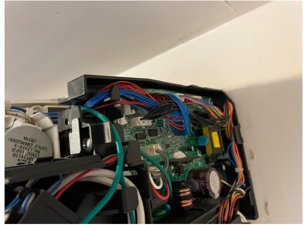
22.エアコンクリーニング
