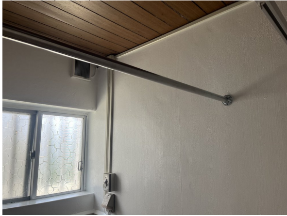
風呂場パイプ取付
