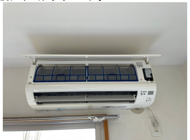
16.エアコンクリーニング
