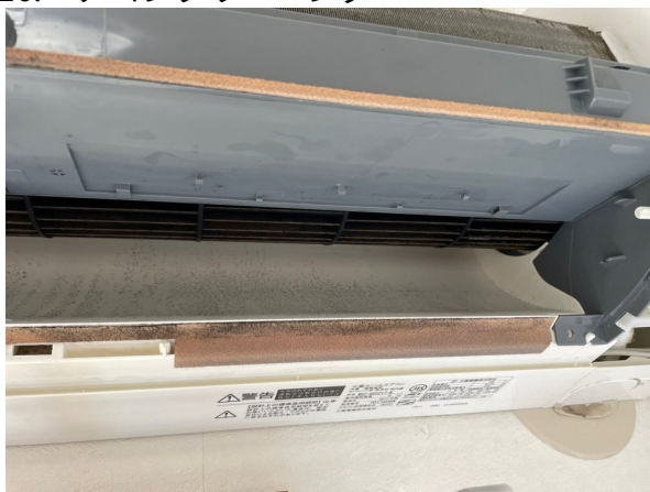
16.エアコンクリーニング
