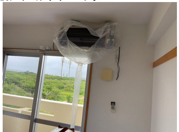
16.エアコンクリーニング
