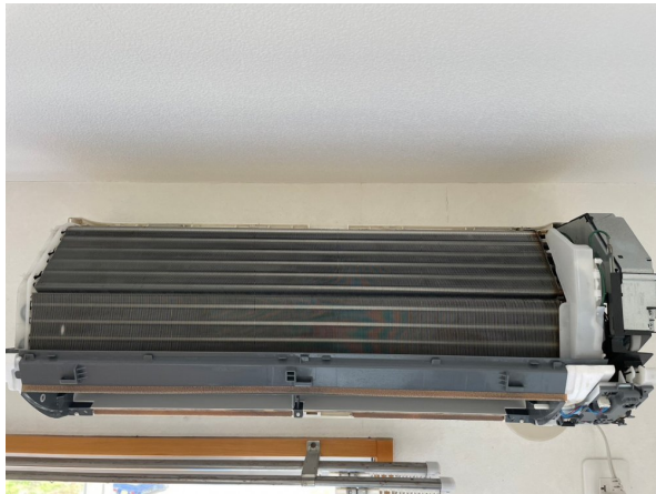
16.エアコンクリーニング
