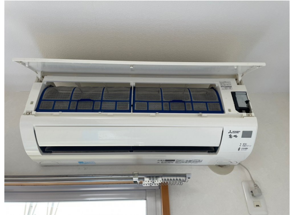
16.エアコンクリーニング
