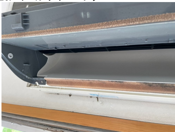
16.エアコンクリーニング
