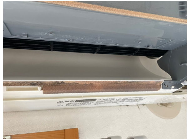
16.エアコンクリーニング
