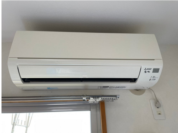
16.エアコンクリーニング
