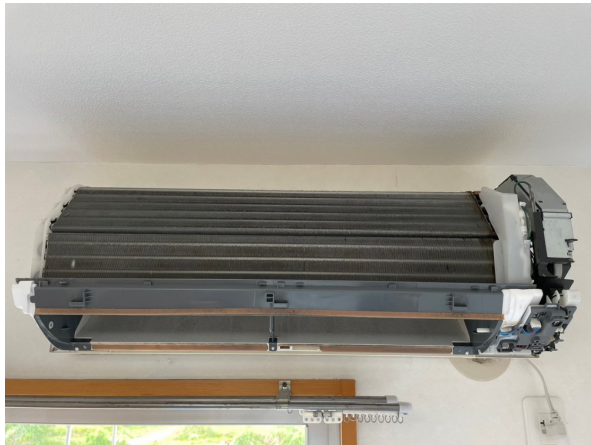
16.エアコンクリーニング
