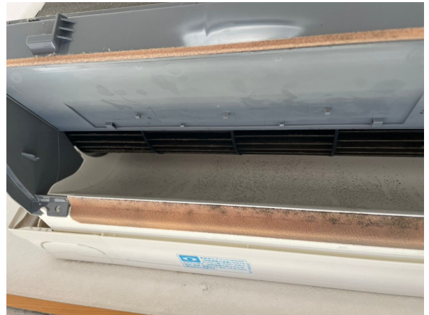
16.エアコンクリーニング
