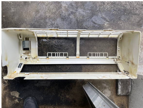
1.エアコンクリーニング
