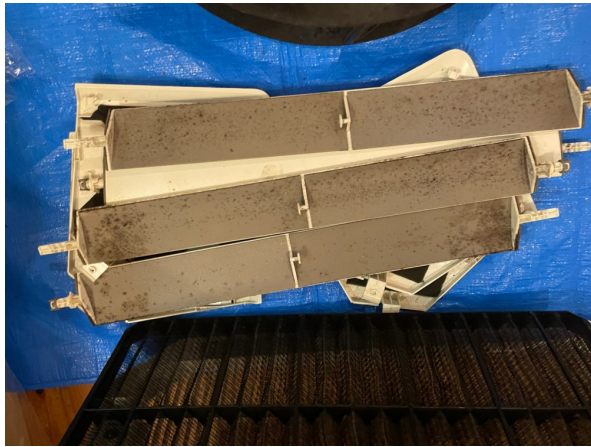
1.エアコンクリーニング
