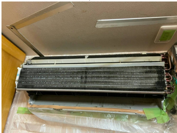
1.エアコンクリーニング
