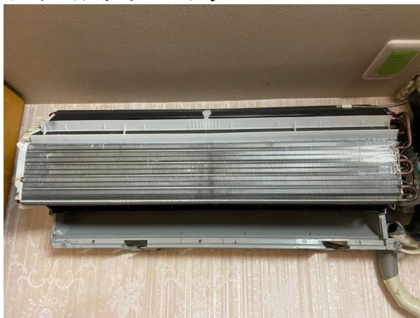
1.エアコンクリーニング
