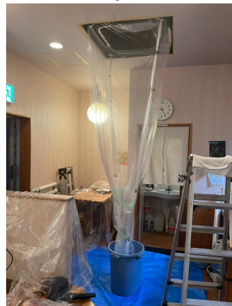
1.エアコンクリーニング
