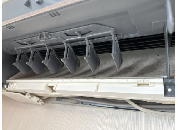
14.エアコンクリーニング
