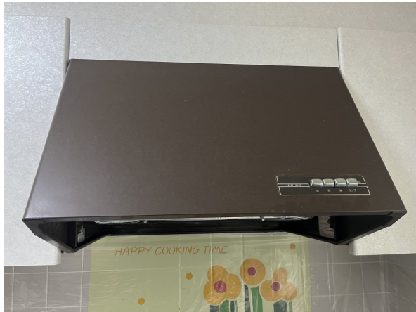
レンジフード取替
