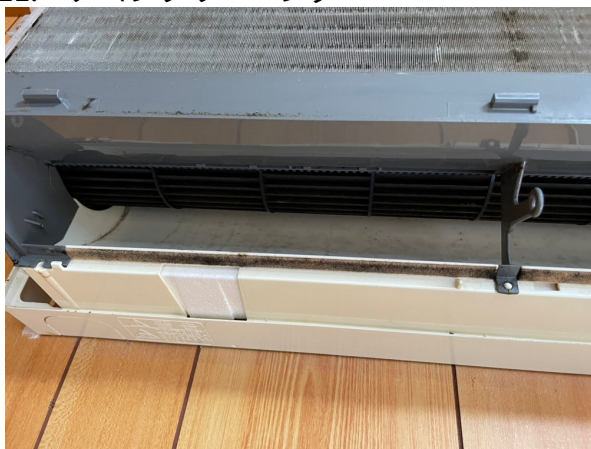
11.エアコンクリーニング
