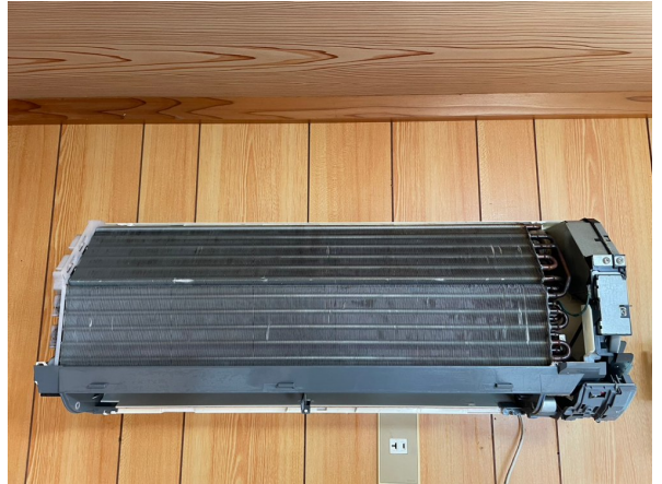
11.エアコンクリーニング
