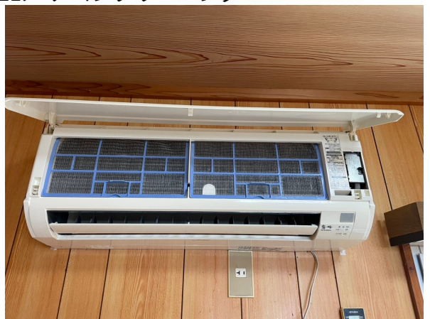
11.エアコンクリーニング
