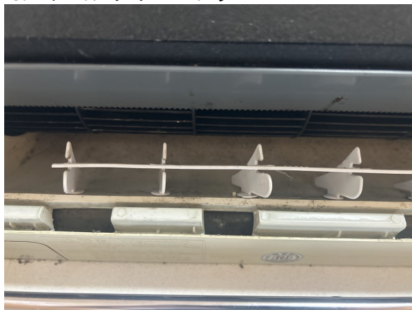
18.エアコンクリーニング
