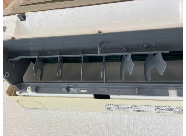
12.エアコンクリーニング
