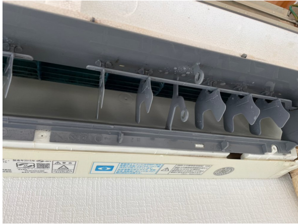
12.エアコンクリーニング
