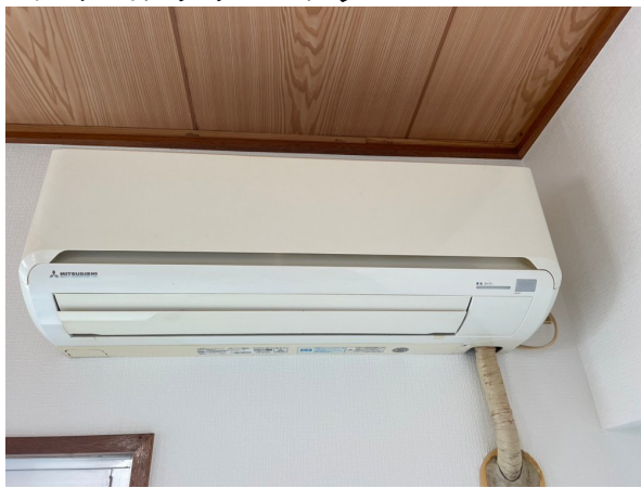
12.エアコンクリーニング
