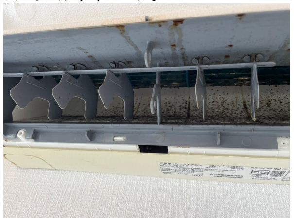
12.エアコンクリーニング
