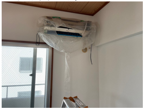
12.エアコンクリーニング
