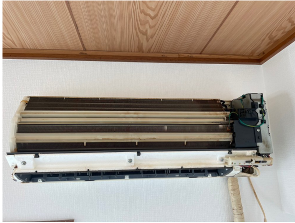
12.エアコンクリーニング
