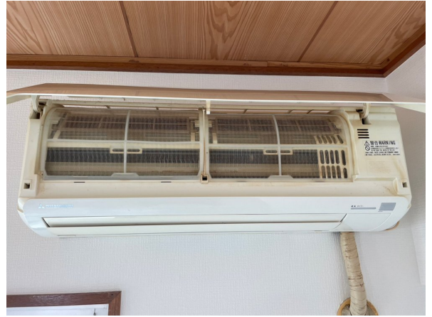
12.エアコンクリーニング
