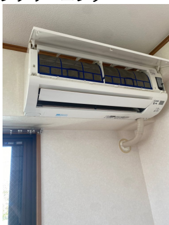
13.エアコンクリーニング
