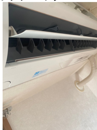
13.エアコンクリーニング
