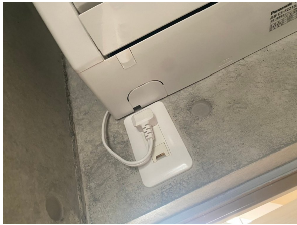
11.エアコンクリーニング
