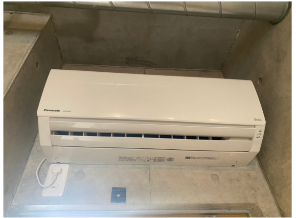
11.エアコンクリーニング
