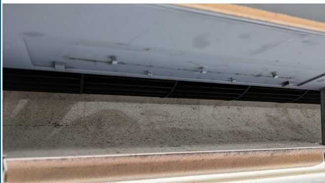
13.エアコンクリーニング
