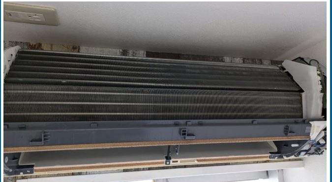
13.エアコンクリーニング
