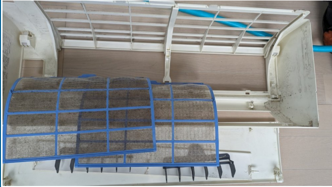
13.エアコンクリーニング
