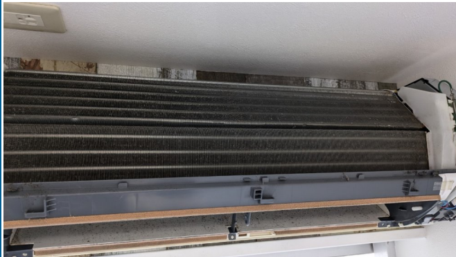
13.エアコンクリーニング
