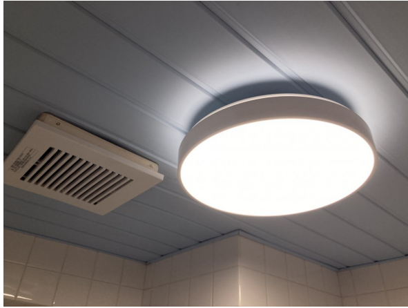
浴室換気扇取替
