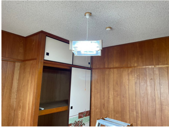
和室照明取替
