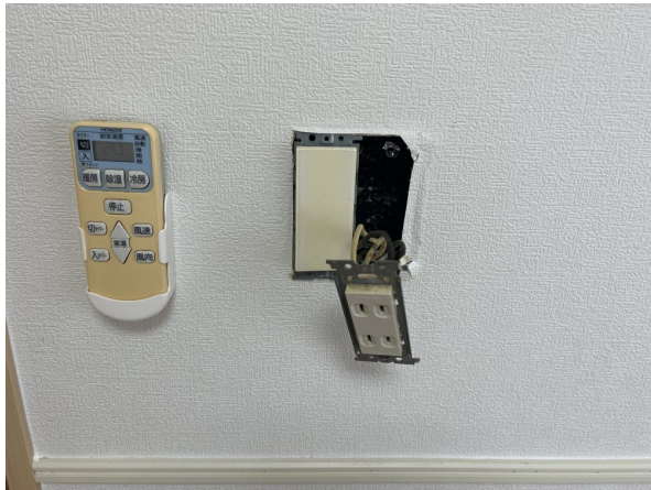
コンセント取替①
