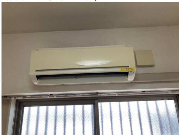
16.エアコンクリーニング
