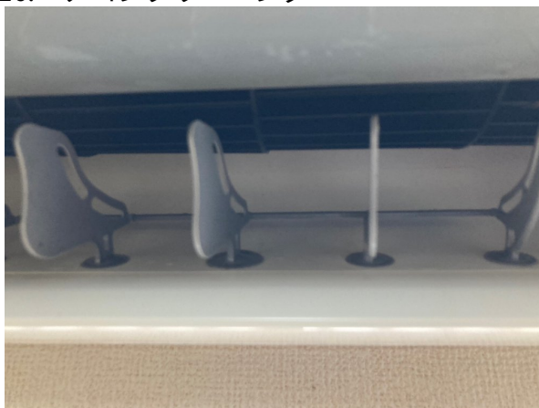
16.エアコンクリーニング
