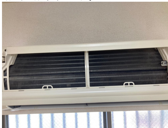
16.エアコンクリーニング
