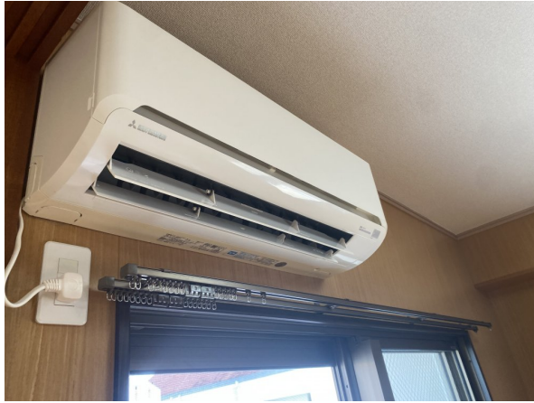
14.エアコンクリーニング
