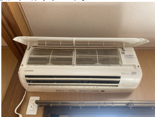
14.エアコンクリーニング
