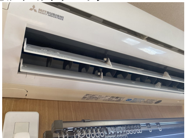
14.エアコンクリーニング
