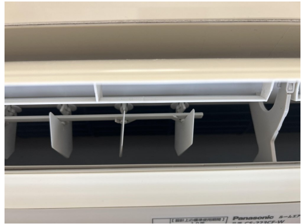
17.エアコンクリーニング
