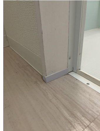
浴室入口木枠補修済み
