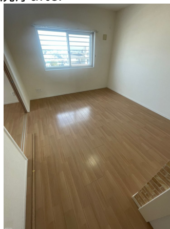
23.床剥離洗浄after
