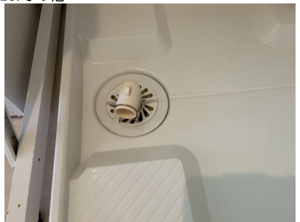
洗濯排水Lボー取付
