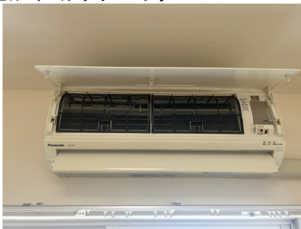
17.エアコンクリーニング
