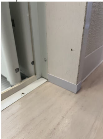
浴室入口木枠補修済み
