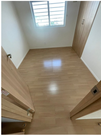
23.床剥離洗浄after
