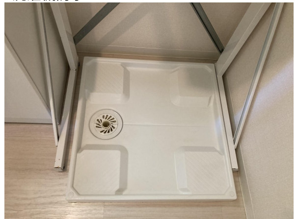
8.洗濯機防水パン
