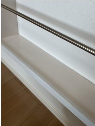
キッチンカウンター下ステン棒修繕・縁補修済み
