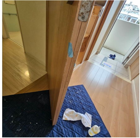
洗面所入口ドアリペア補修 before
