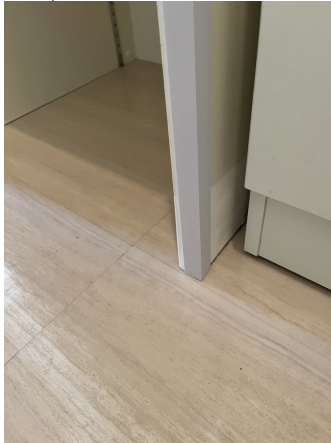
脱衣所棚板補修済み
