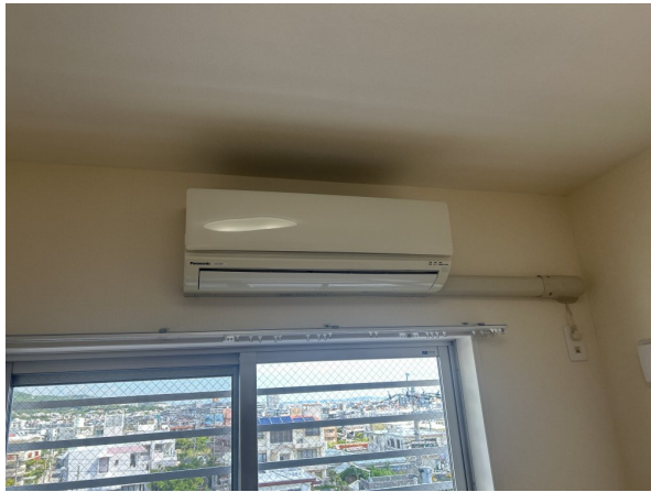
17.エアコンクリーニング
