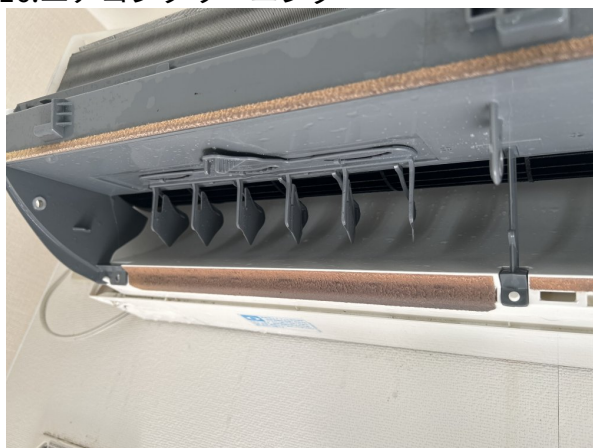
16.エアコンクリーニング
