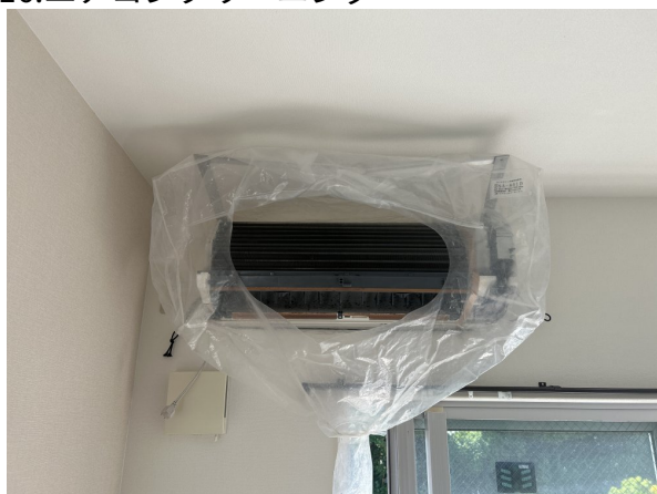
16.エアコンクリーニング
