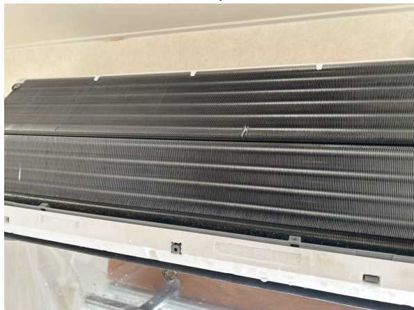
13.エアコンクリーニング
