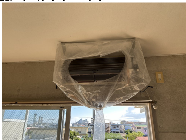
11.エアコンクリーニング
