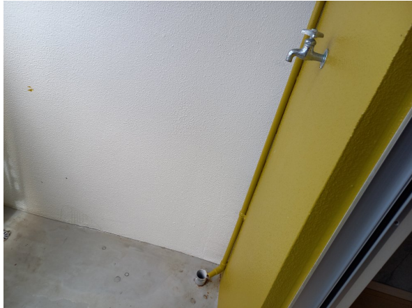
5.洗濯機防水パン
