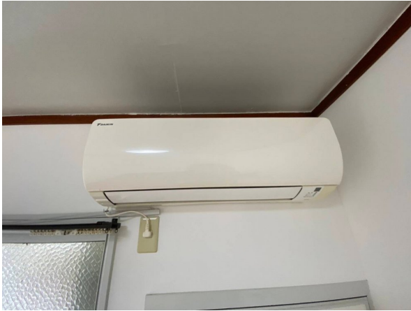
12.エアコンクリーニング
