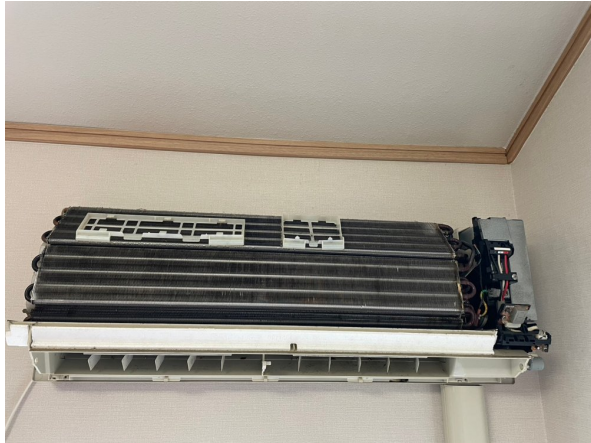
16.エアコンクリーニング
