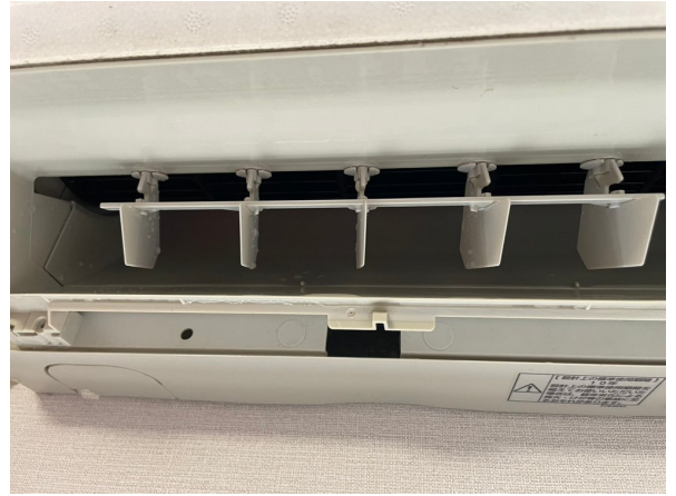
16.エアコンクリーニング
