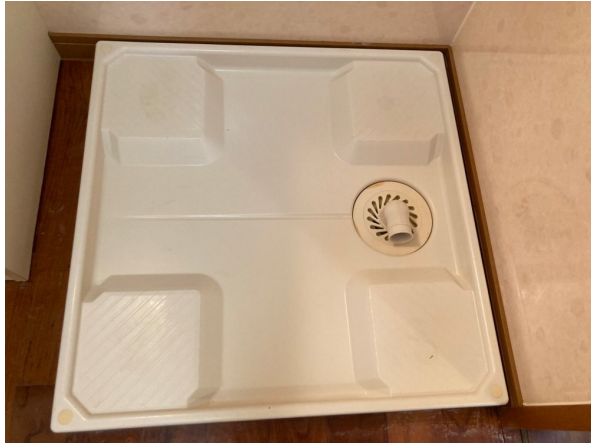
7.洗濯機防水パン
