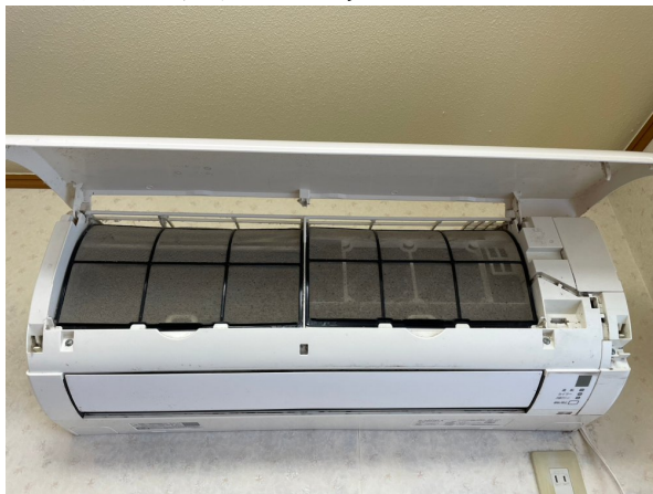
16.エアコンクリーニング
