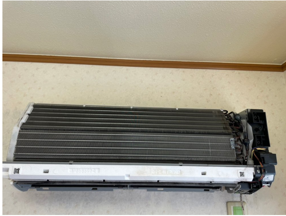
16.エアコンクリーニング
