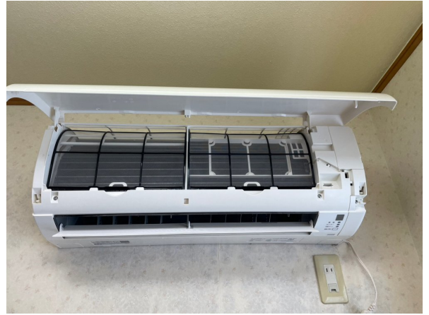
16.エアコンクリーニング
