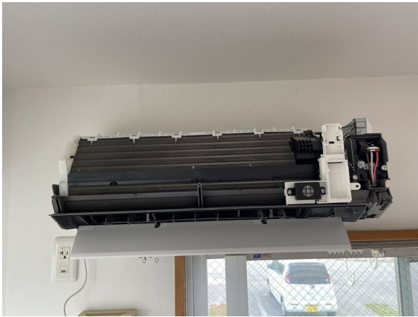
16.エアコンクリーニング
