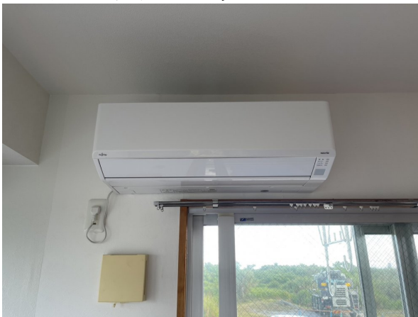
16.エアコンクリーニング
