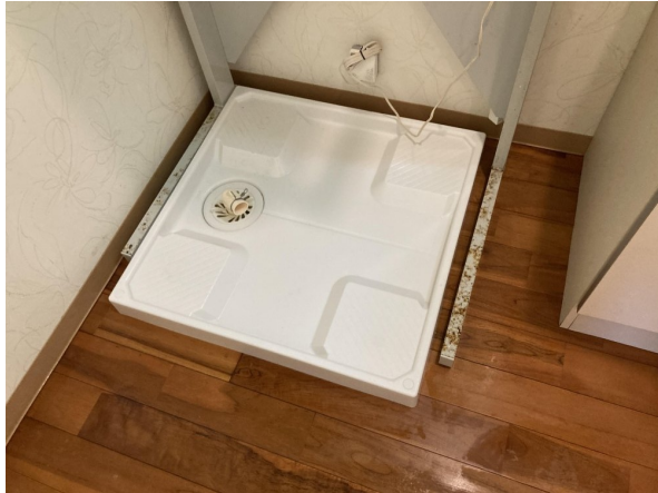
洗濯排水Lボー取付
