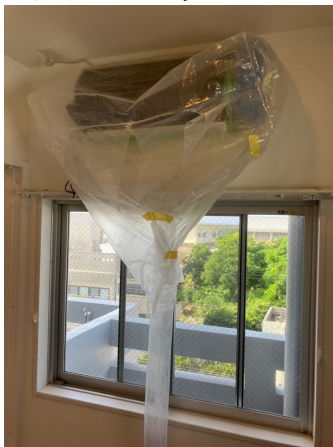
18.エアコンクリーニング
