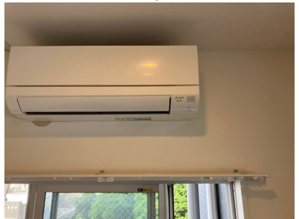
18.エアコンクリーニング
