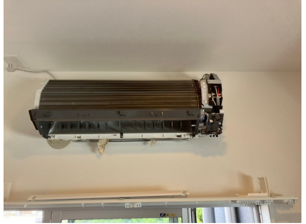
18.エアコンクリーニング
