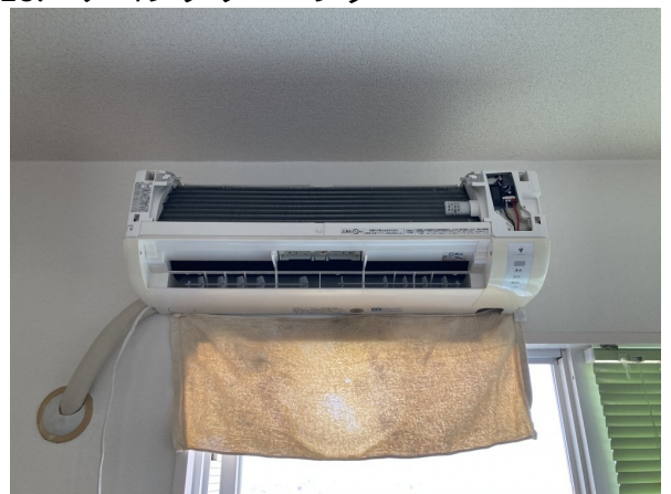
エアコンクリーニング①
