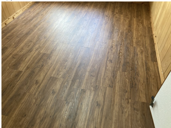
床塩ビタイル張り
