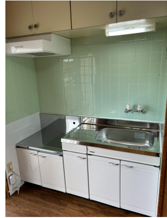
キッチン取替・レンジフード取付け
