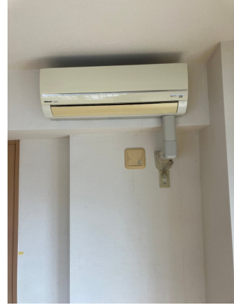
16.エアコンクリーニング
