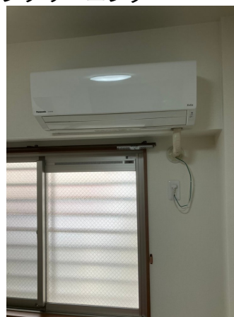
17.エアコンクリーニング
