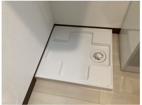
8.洗濯機防水パン
