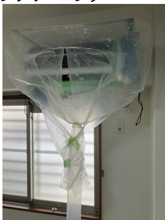
17.エアコンクリーニング
