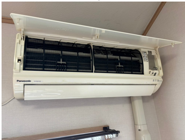
16.エアコンクリーニング
