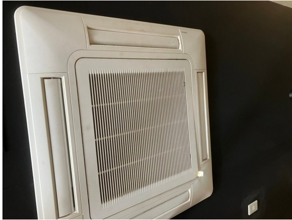
4.エアコンクリーニング
