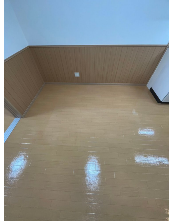
16.床剥離洗浄after
