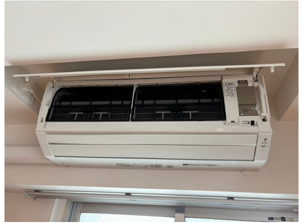
16.エアコンクリーニング
