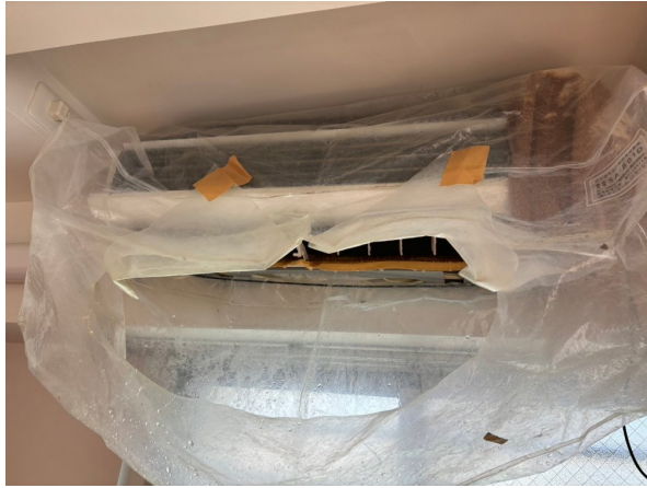
16.エアコンクリーニング
