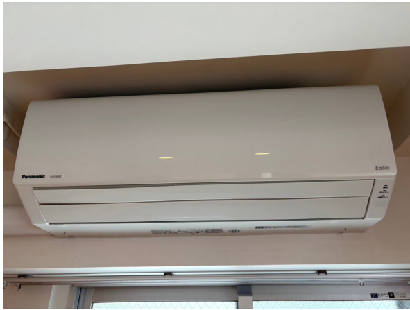
16.エアコンクリーニング
