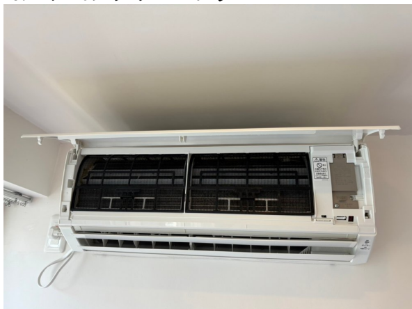
16.エアコンクリーニング
