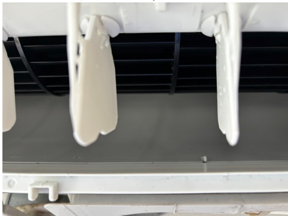
16.エアコンクリーニング
