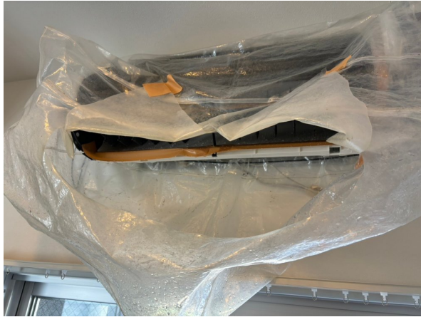
15.エアコンクリーニング
