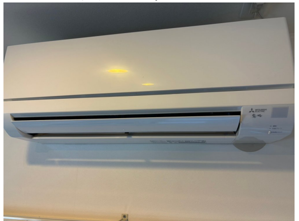
15.エアコンクリーニング
