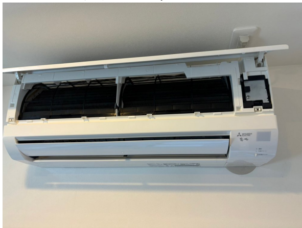
15.エアコンクリーニング
