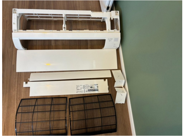
15.エアコンクリーニング
