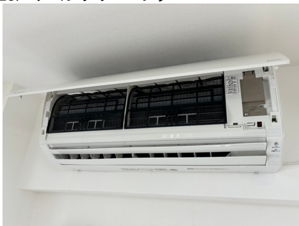
18.エアコンクリーニング
