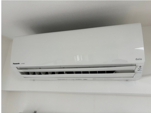
18.エアコンクリーニング
