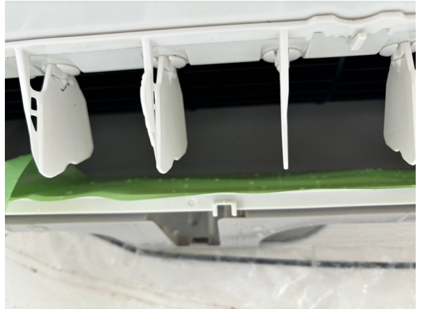
18.エアコンクリーニング
