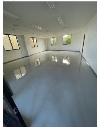
10.床剥離洗浄after
