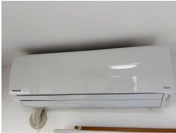
15.エアコンクリーニング
