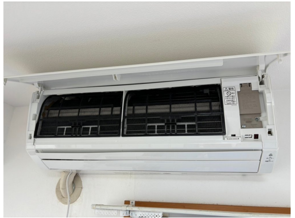
15.エアコンクリーニング
