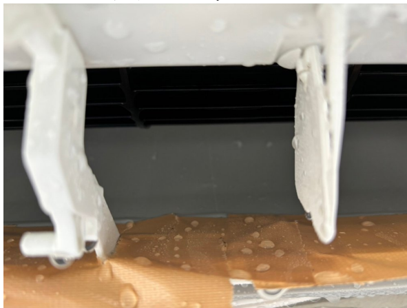
15.エアコンクリーニング
