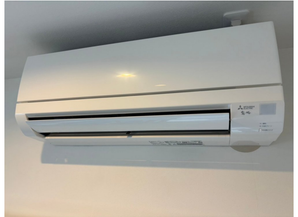
16.エアコンクリーニング
