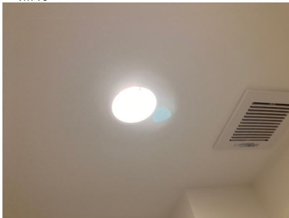
トイレ電球取付
