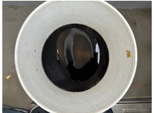
16.エアコンクリーニング
