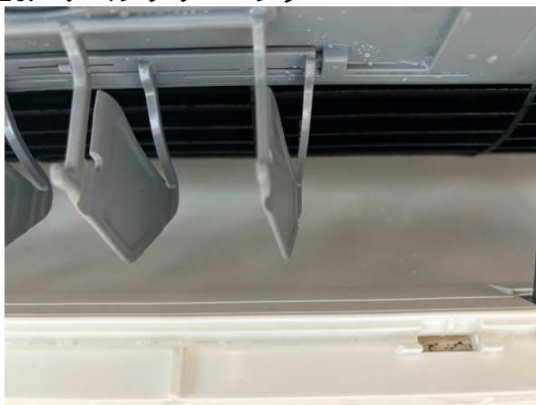
16.エアコンクリーニング
