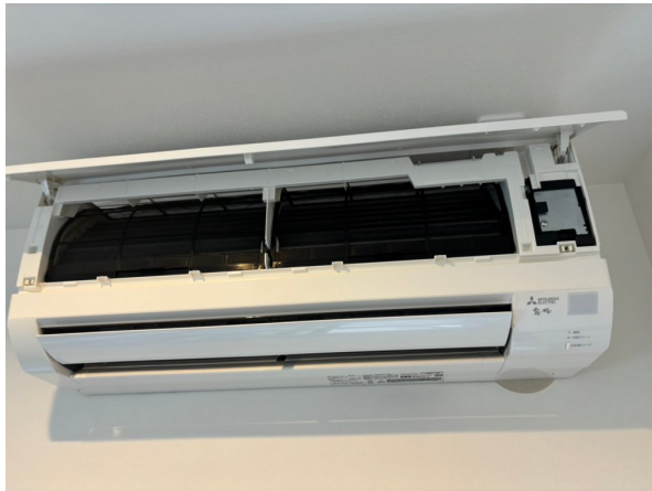
16.エアコンクリーニング
