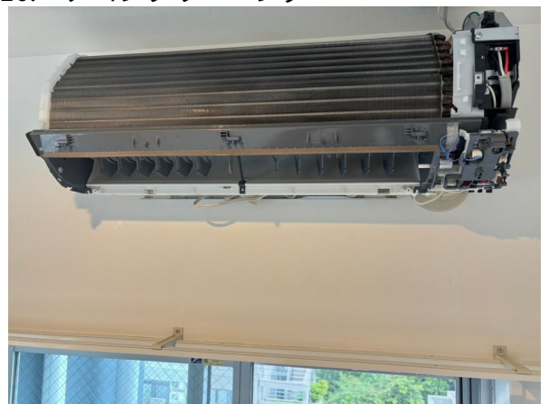
16.エアコンクリーニング
