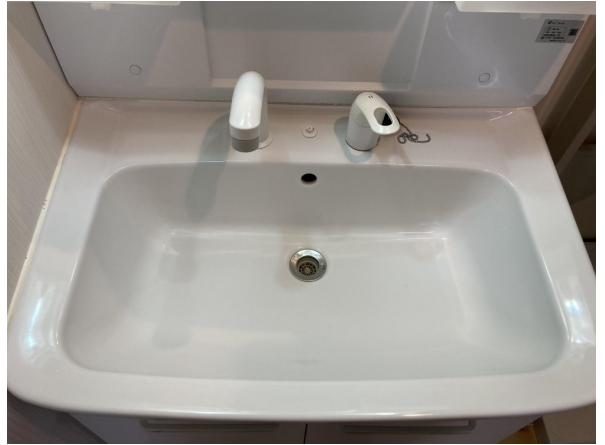
排水ゴム蓋チェーン破損
