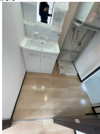
19.床剥離洗浄after
