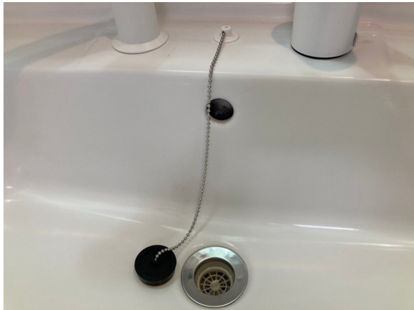
排水ゴム取替済み
