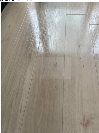
19.床剥離洗浄after
