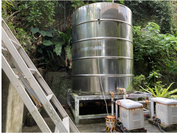
2. 受水槽フェンスまわり
