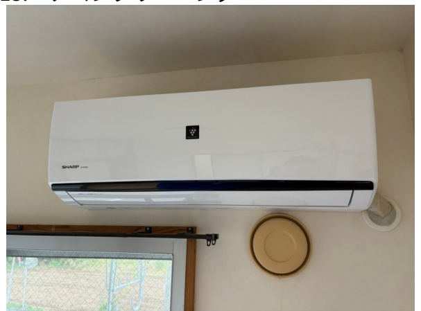
13.エアコンクリーニング
