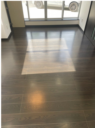
20.床剥離洗浄after
